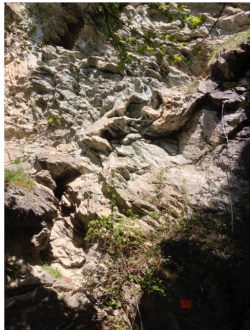
Paroi rocheuse de La Forclaz
