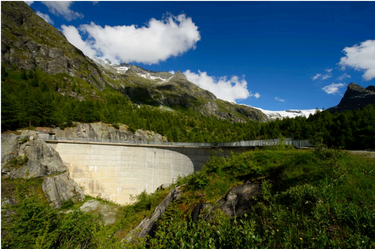
Barrage de Ferpècle (Photo: S. Ruttimann)
